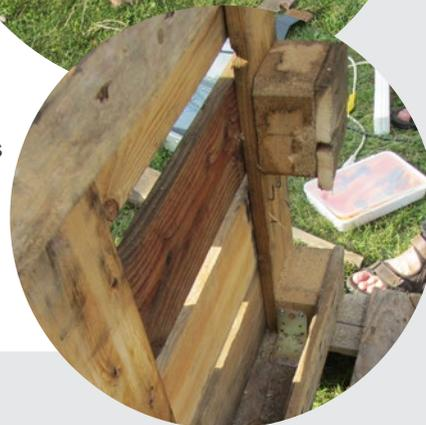
Alternativ dazu kann – wenn genügend Material (5 Paletten) vorhanden ist – auch jeweils eine weitere Palette für die kurze Seite verwendet werden: Zwei Paletten werden rechts und links passend beschnitten, die Verbindung mittig bleibt bestehen und trägt zur Stabilität bei. Die Palettenteile werden dann mit den schon montierten Seitenteilen des Hochbeets verschraubt.
